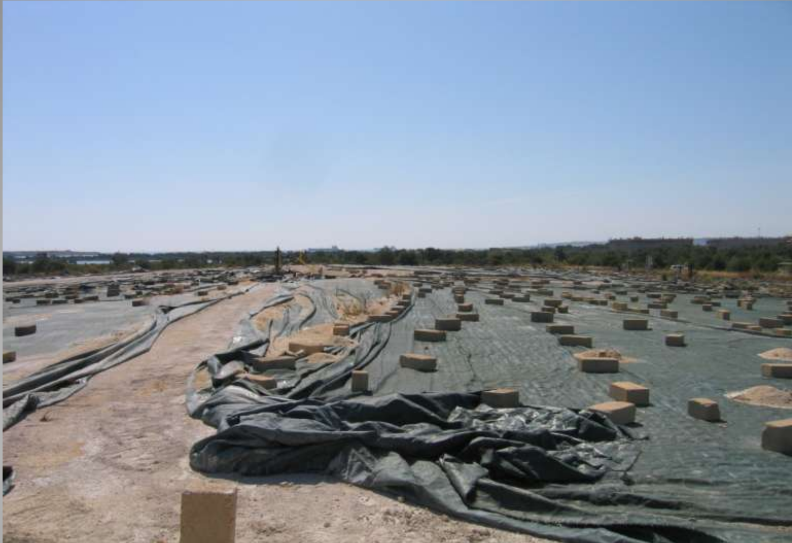
Bonifica su impianto consortile IAS – Priolo Gargallo (SR): vista dell'area di intervento
