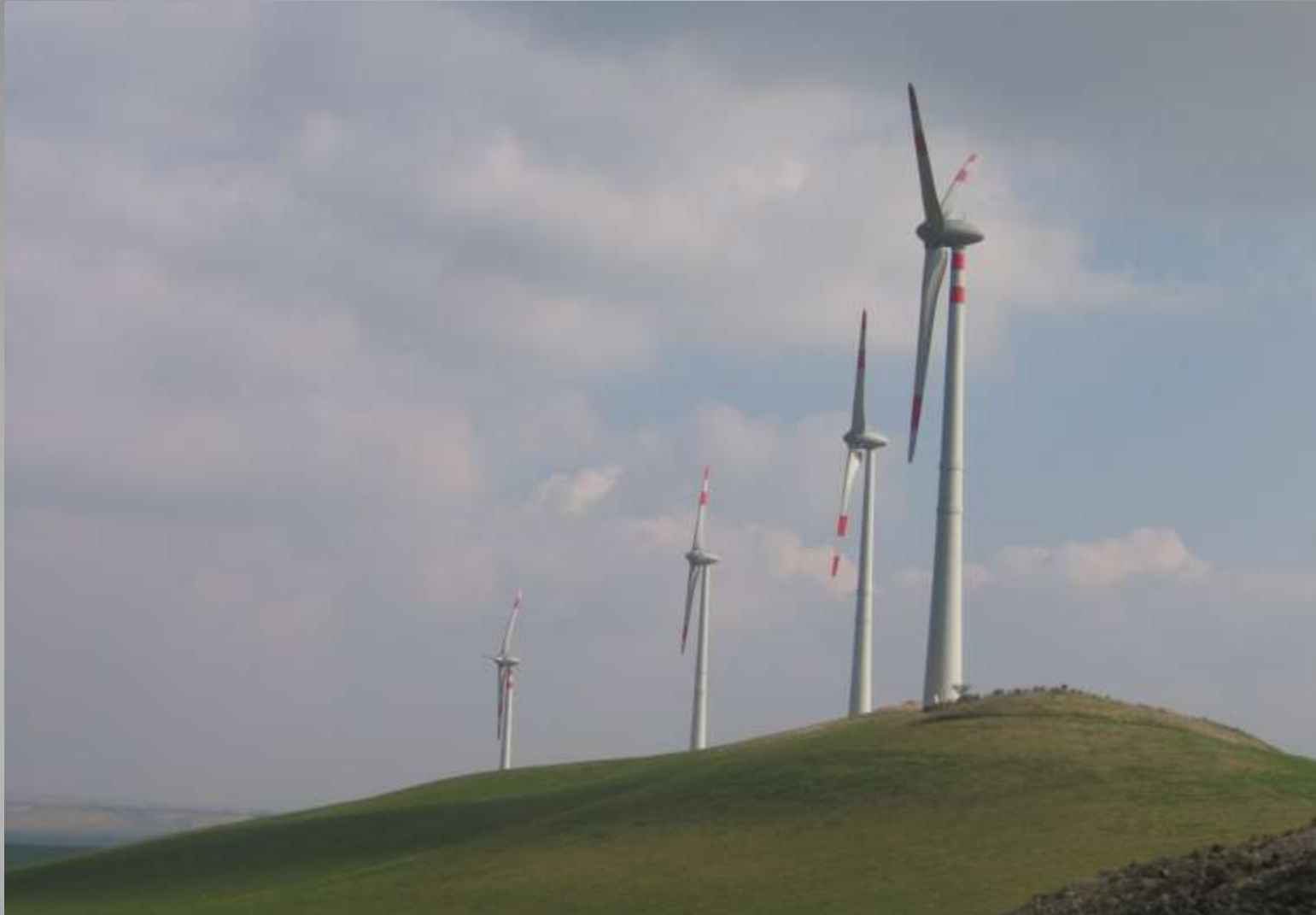
Costruzione di una centrale eolica – Comune di Alberona (FG): vista dell'impianto ultimato
