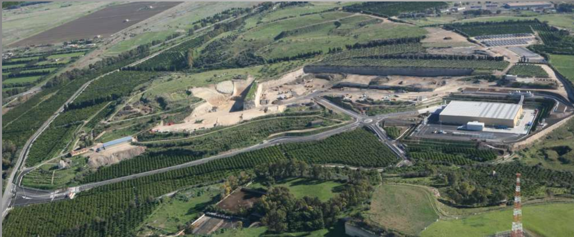
Impianto di selezione e trattamento della frazione secca e di biostabilizzazione della frazione umida RSU Contrada Codavolpe – Catania Vista panoramica
