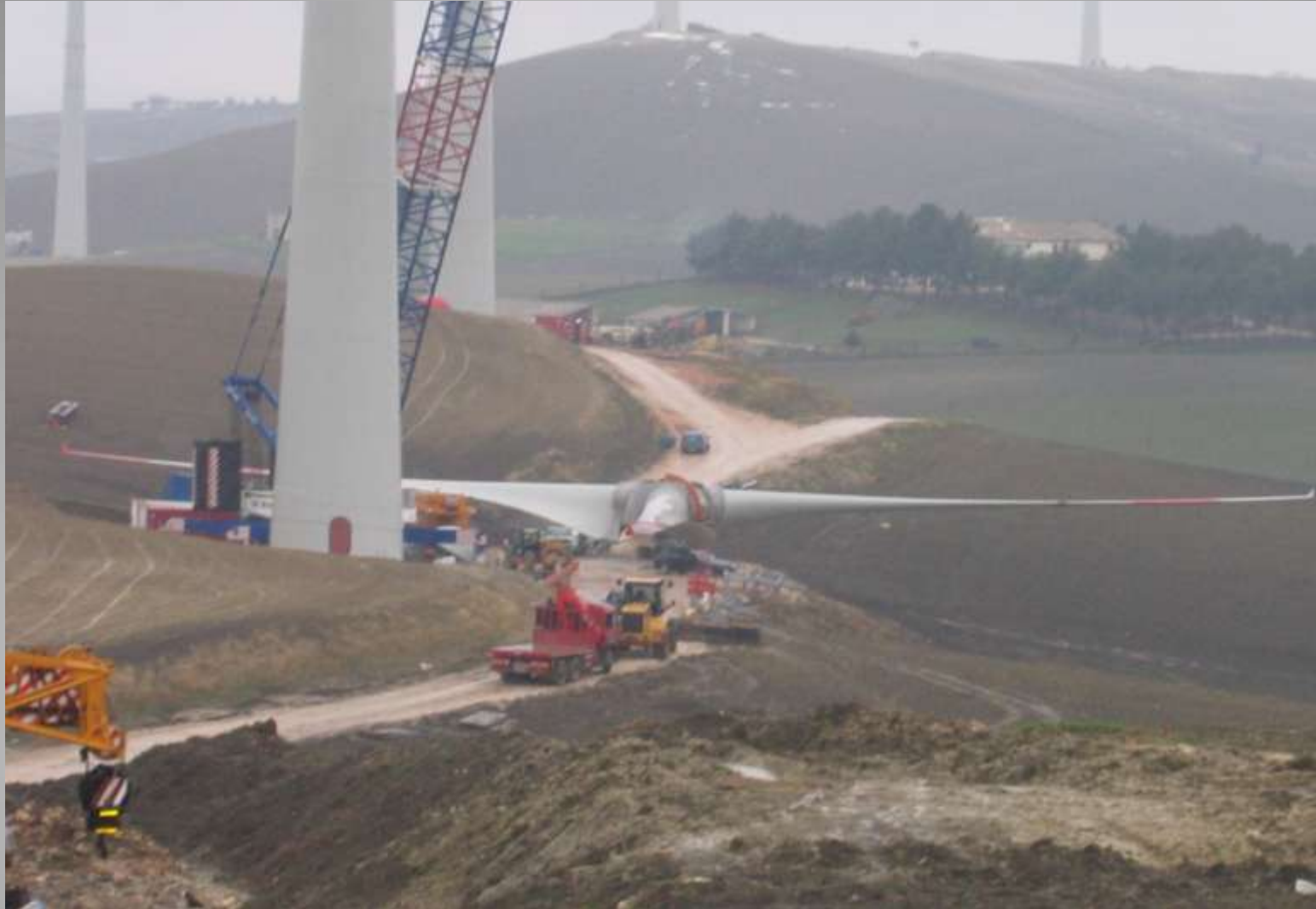
Costruzione di una centrale eolica – Comune di Alberona (FG)
