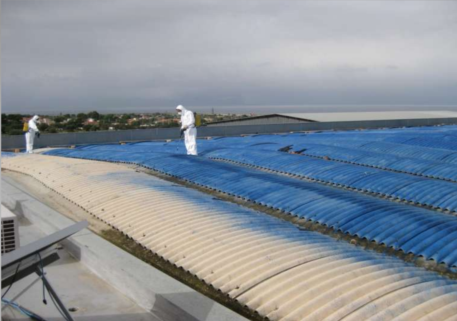
C.da Feudo Orsa – Cinisi (PA): Messa in sicurezza e rimozione della copertura
