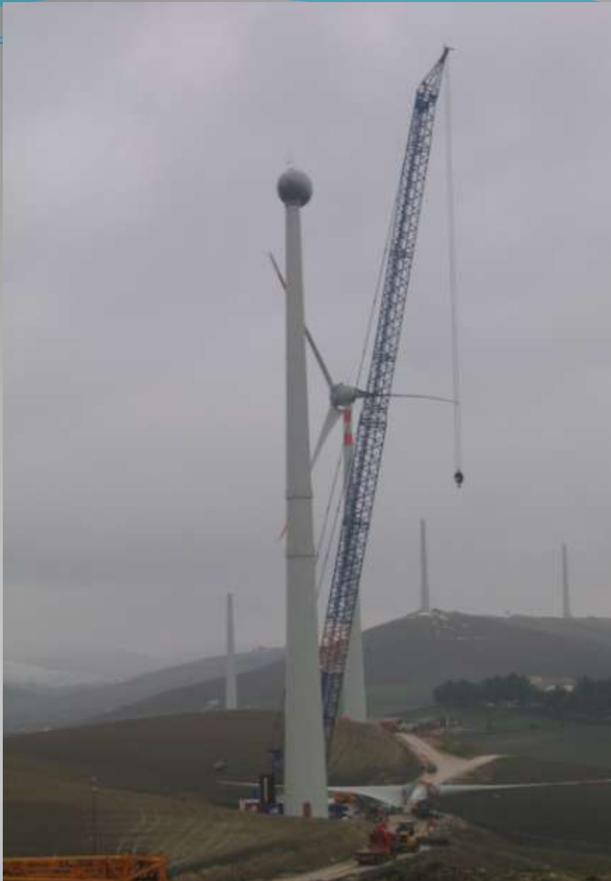
Costruzione di una centrale eolica – Comune di Alberona (FG)
