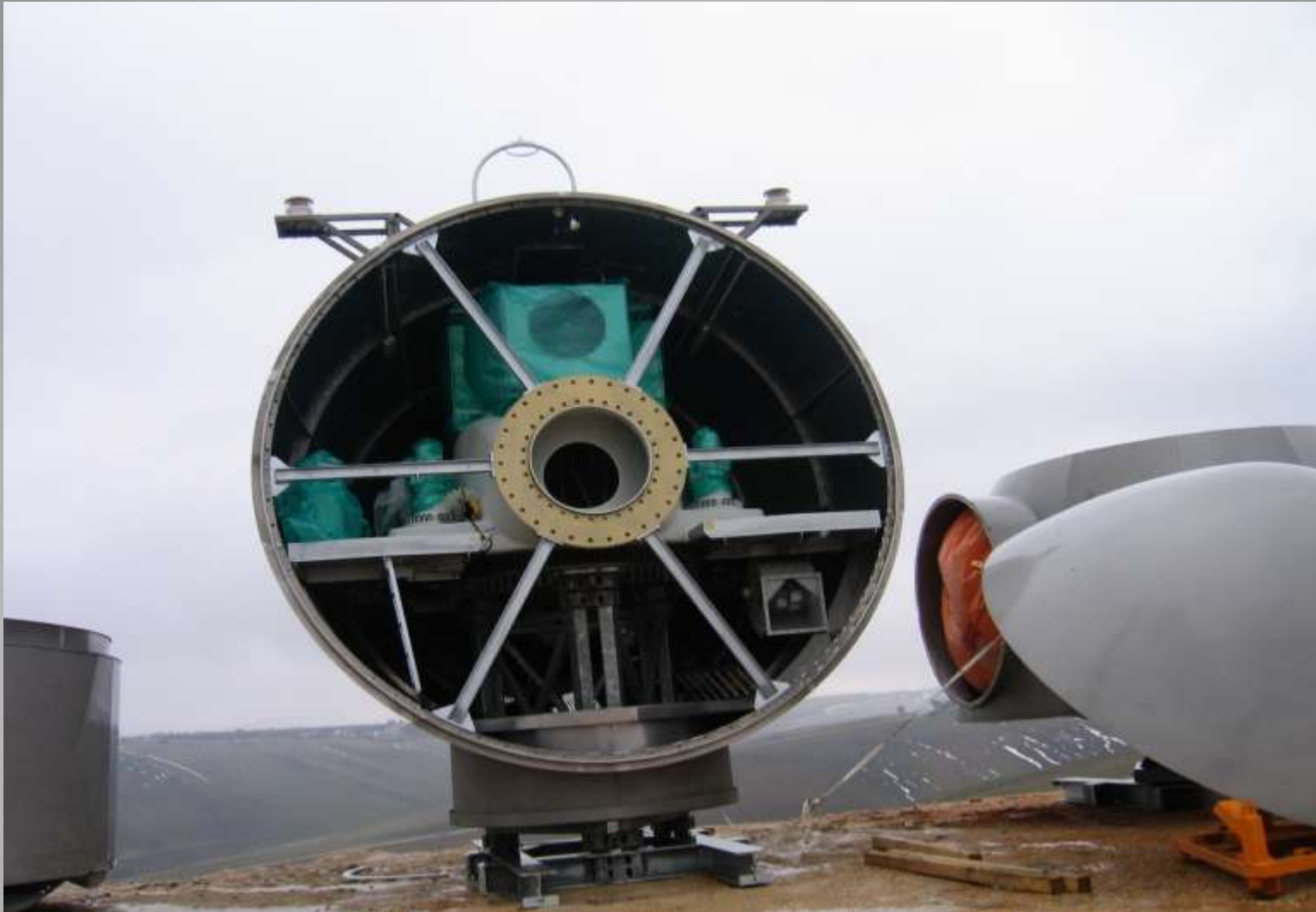
Particolare del montaggio di una “navicella” di una pala eolica – Comune di Alberona (FG)
