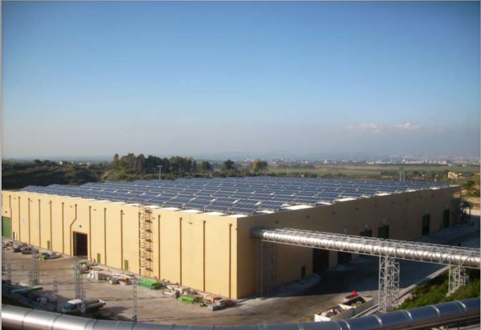
Impianto fotovoltaico – C.da Codavolpe (CT): vista dell'impianto
