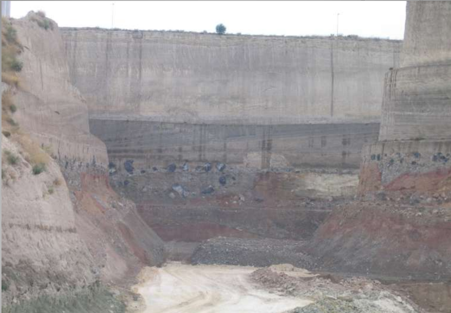
Particolare del profilamento degli argini di una discarica per Rifiuti Speciali Pericolosi (R.S.P.) – Comune di Catania
